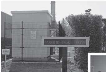
(写真左上) モニタリングポストの屋外設備では、電光掲示板に数値が表示されます。
