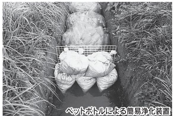
ペットボトルによる簡易浄化装置
