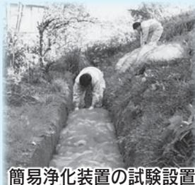
簡易浄化装置の試験設置
