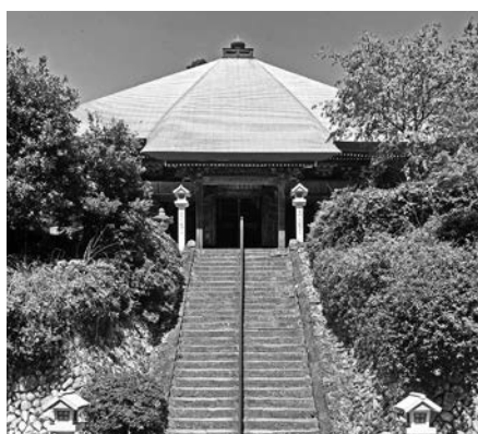
油山寺本堂の外観
