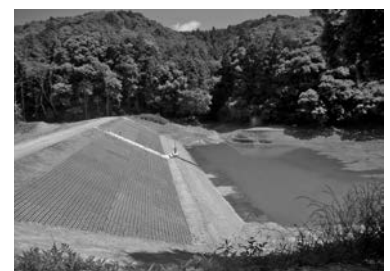
堤体の補強工事完了の山田池(右側が池側)
