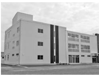
袋井北小学校 増築棟
