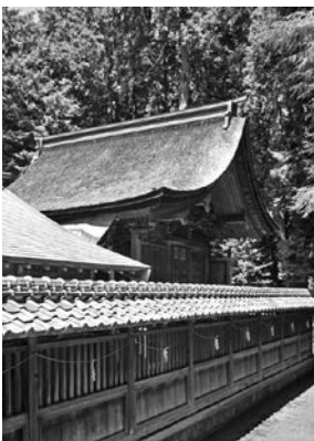
富士浅間宮本殿(修繕前)
