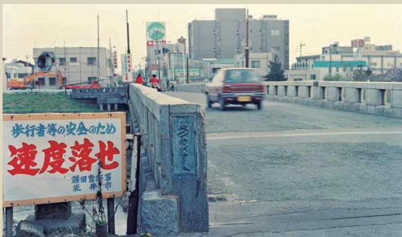
▲橋はコンクリート製で長さ98メートル、幅6.4メートル。御影石で作られた手すりとしゃれた白い照明灯があり、当時としては立派なものでした。
