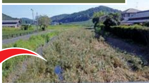
浚渫前の小笠沢川
