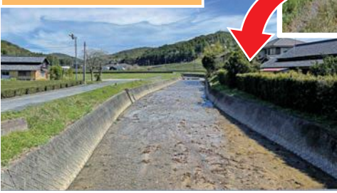
浚渫後の小笠沢川
