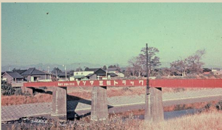
全長99メートル、幅2.6メートル、4本の橋脚で支える鋼鉄製の橋でした。(写真提供:飯島正資さん)
