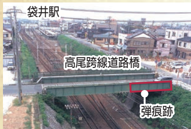
架け替え前の高尾跨線道路橋 (撮影:平成20年)
