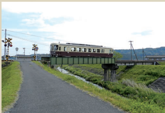
左側が鉄橋、右側がコンクリート橋でできた一宮川橋梁 (森町方面から撮影)
