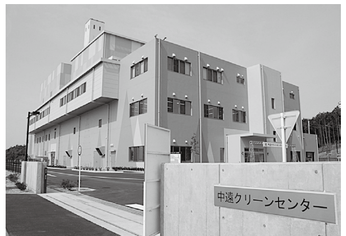
新しいごみ処理施設「中遠クリーンセンター」が稼働(3月24日)
