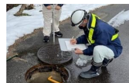
下水道被害調査
