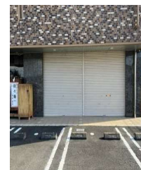
【愛野駅周辺の空き店舗】
