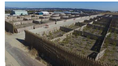
防潮堤完成部分 (袋井市湊地内)
