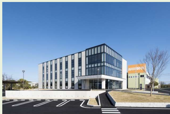
市内の ZEB 事例（静岡製機株式会社本社）
