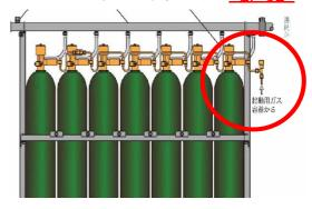
作業終了後は、<u>閉止弁等を【開】</u>の状態にするとともに、二酸化炭素消火設備を **通常時の状態に復旧させ、**建物関係者及び作業員の双方で確認をしてください。
