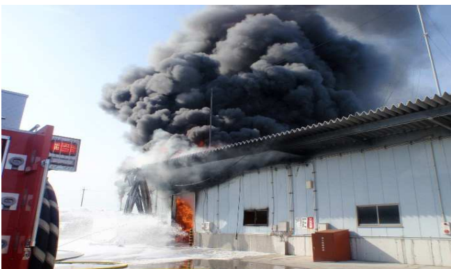
かさい 火災 Incêndio
