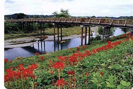
周囲の自然景観と調和した木製の新屋橋
