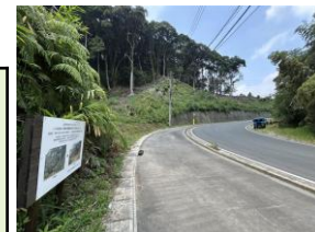
重要インフラ施設 周辺森林整備業務 委託（大谷） 伐採後の状況
