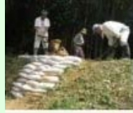
漏水箇所の補修
