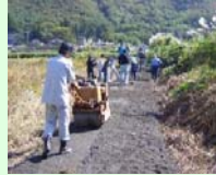
未舗装農道の舗装
