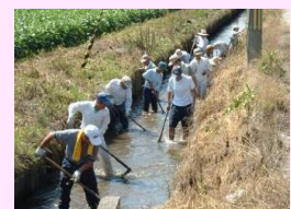
水路の泥上げ
