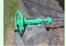
ゲート、バルブの更新
