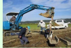
コンクリート水路の更新
