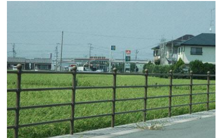
田園景観と調和するよう道路の防護柵の色彩に配慮している。(浅羽西地区)
