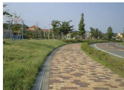
カラー舗装や緑化により景観に配慮した歩道 (下田市)
