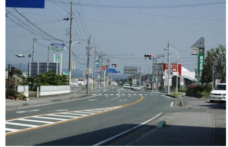
県道袋井大須賀線の浅羽支所付近 沿道
