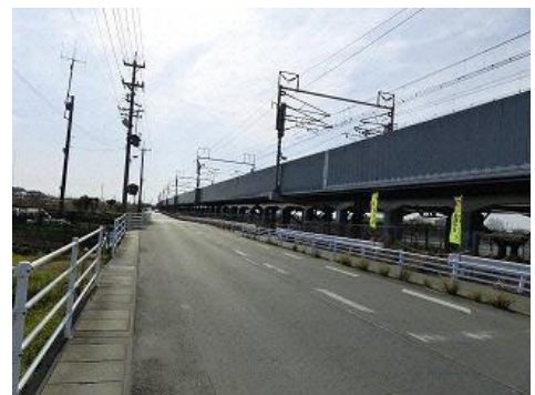
J R 東海道新幹線の高架 (袋井南地区)
