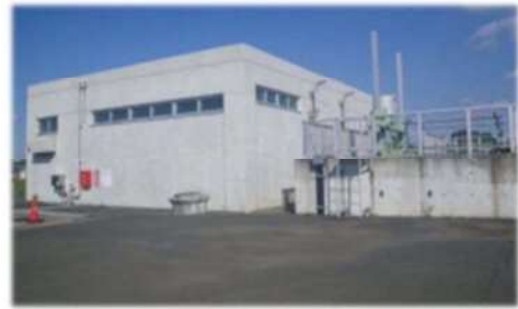
▼雨水ポンプ場（出典：国交省 HP）
