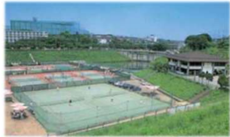
▼平常時はテニスコートに利用している雨水貯留施設（出典：国交省 HP）
