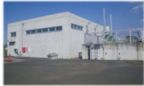
▼雨水ポンプ場（出典：国交省 HP）
