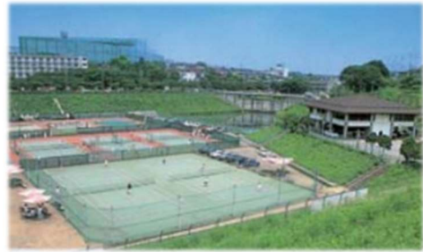
▼平常時はテニスコートに利用している雨水貯留施設（出典：国交省 HP）
