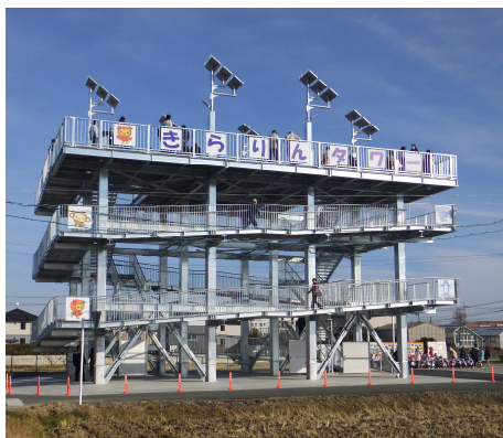
津波避難施設の建設（浅羽南地区）
