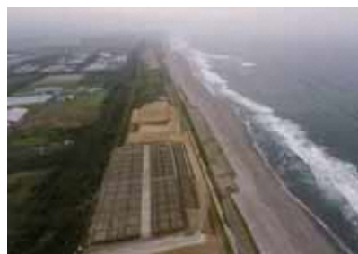
防潮堤整備事業
