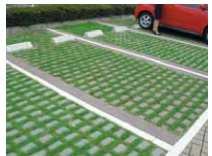
緑化ブロックによる 駐車場の緑化
