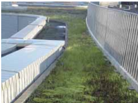
屋上緑化の取組（月見の里学遊館）
