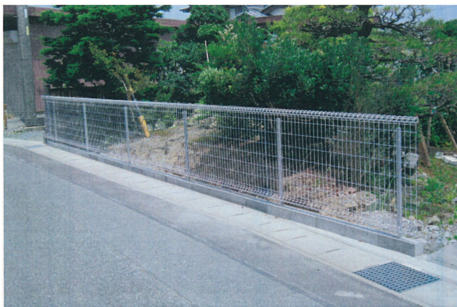
老朽化したブロック塀を撤去して、ネットフェンスに改善した事例
