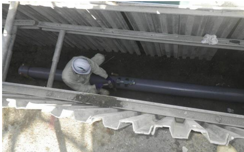
下水道管渠築造工事の様子
