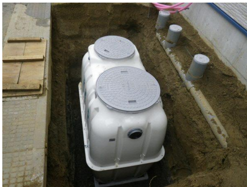
合併処理浄化槽の埋設状況
