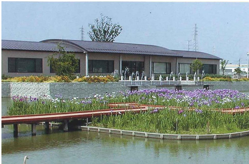
袋井浄化センター（新池）
