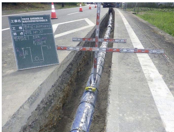
写真 4 ポリエチレン管の工事写真
