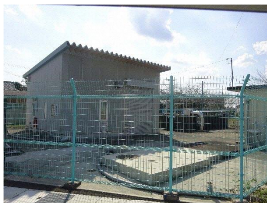
写真3 山梨ポンプ場
