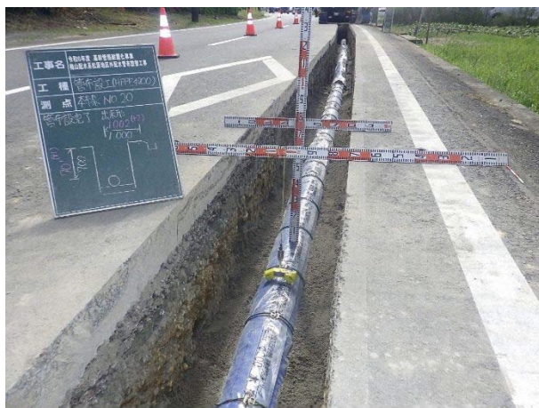
写真 4 ポリエチレン管の工事写真
