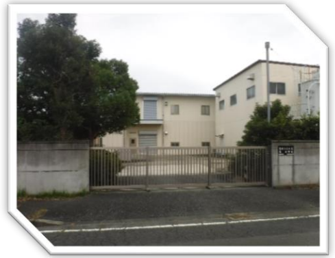
上田ポンプ場
