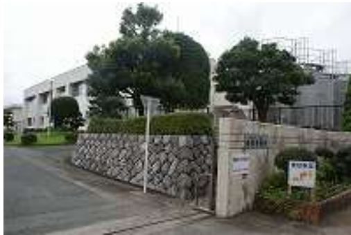
寺谷浄水場(県の施設)
