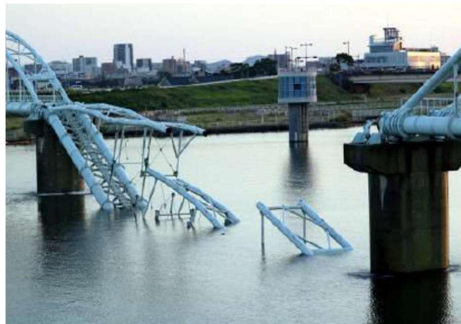
写真2 老朽化(腐食)による水管橋落下
