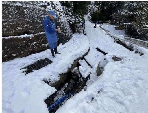
輪島市 送水管損傷
