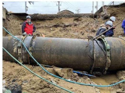
七尾市 送水管損傷
