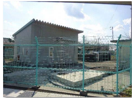
«山梨ポンプ場»
