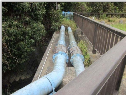
「第3配水池送配水管：天神橋添架管」
