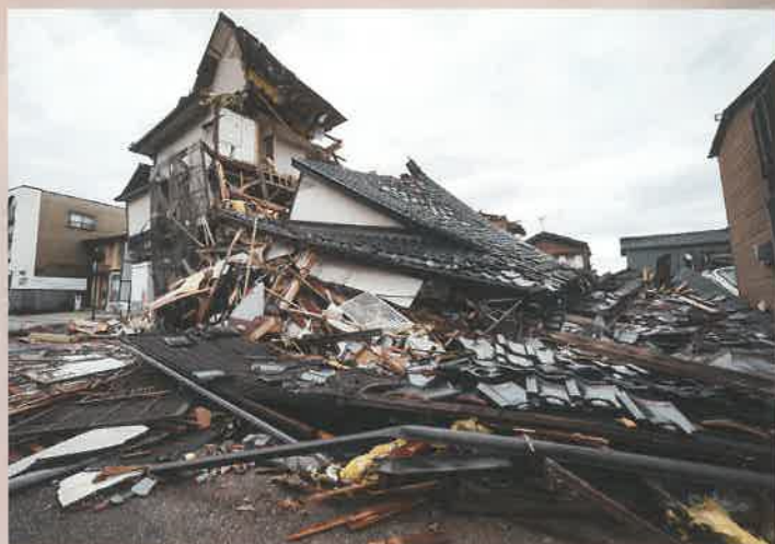
全壊した木造家屋(輪島市)
