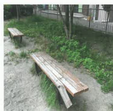
公園のベンチの破損
