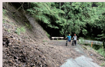
▲がけ崩れの現場を見学
