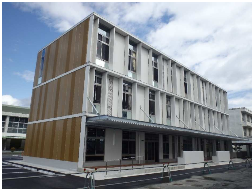
【周南中学校特別教室棟増築】
