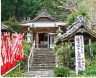
26 建福寺薬師堂 川会 平成6年3月28日 市指定文化財建造物 貞享4(1687)年の修理記録をもつ入母屋造の三間堂。
