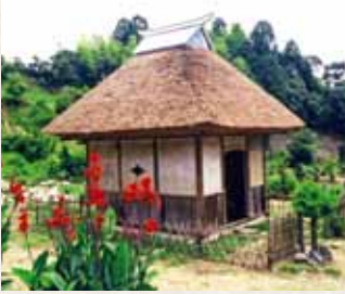
24 雲谷寺東司 大谷 昭和60年3月19日 市指定文化財建造物
