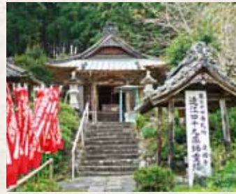
26 建福寺薬師堂 川会 平成6年3月28日 市指定文化財建造物 貞享4(1687)年の修理記録をもつ入母屋造の三間堂。
