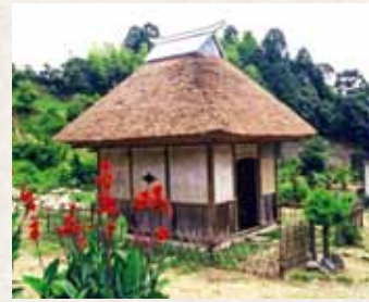
24 雲谷寺東司 大谷 昭和60年3月19日 市指定文化財建造物
