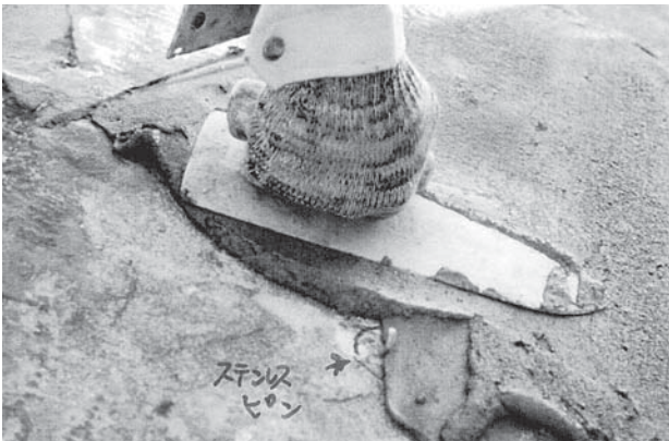
第2次保存修理 塔身上部上下塗モルタル塗作業
