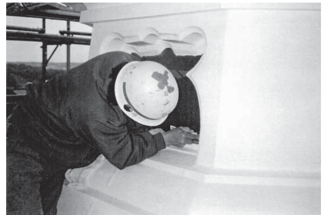
第2次保存修理 天窓塗装後のクリーニング作業
