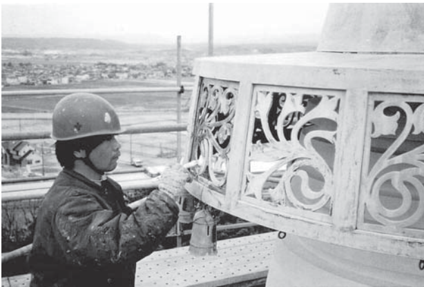
第2次保存修理 相輪防水剤塗布作業
