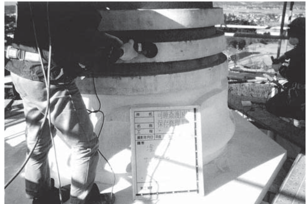
第2次保存修理前 相輪下部旧塗装撤去作業
