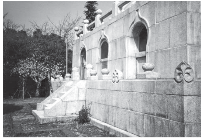
第2次保存修理竣工 西面基壇
