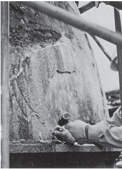
第 1 次保存修理 風化表面材撤去
