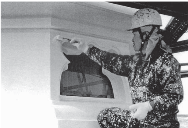
第2次保存修理 塔身上部トップコート塗装作業
