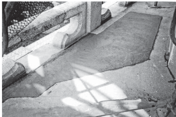
第2次保存修理 基壇上部歩廊表面洗い出し仕上げ状況
