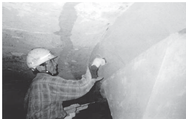
第2次保存修理 基壇内部梁部漆喰仕上げ作業
