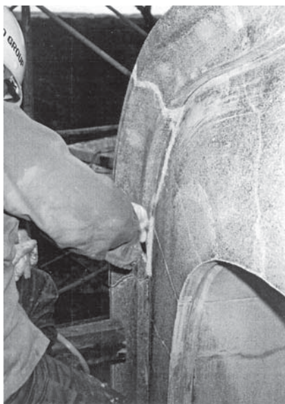
第 1 次保存修理 防水剤塗布作業状況
