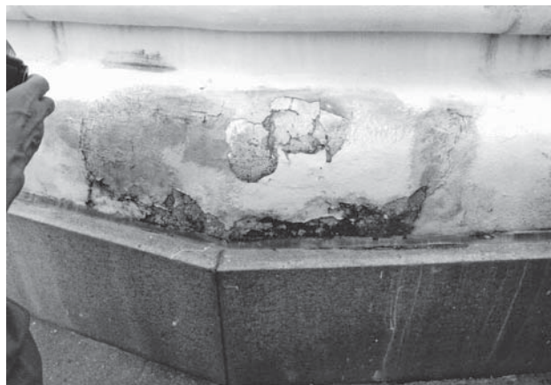
第2次保存修理前 塔身下部破損状況
