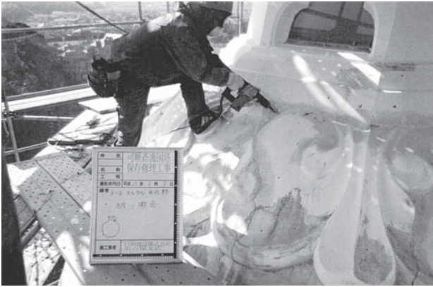
第2次保存修理 エポキシ樹脂注入固定後表面材撤去作業
