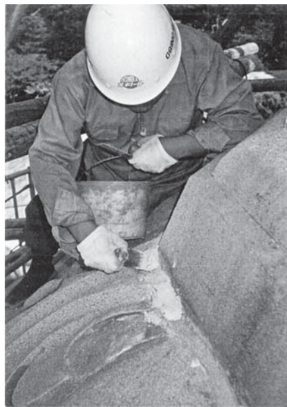
第 1 次保存修理 防水剤充填状況
