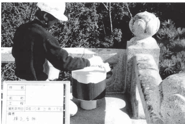
第2次保存修理 換気筒ウレタン塗装作業
