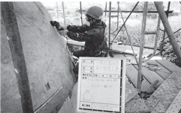
第2次保存修理 塔身上部表面材撤去作業状況
