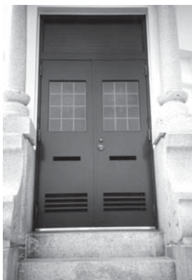
第2次保存修理竣工 塔身入口内部
