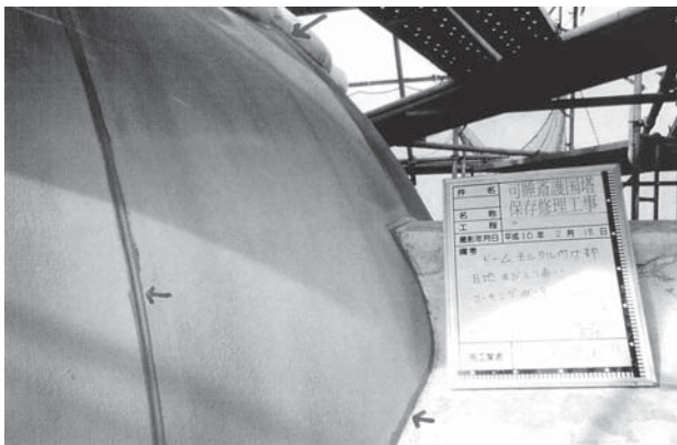
第2次保存修理 モルタル仕上各所取合コーキング状況
