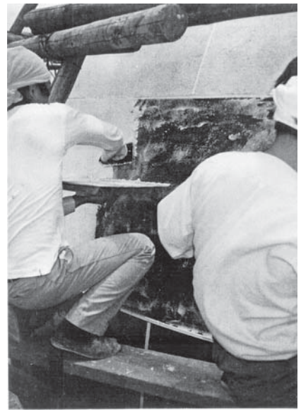
第1次保存修理 左官工事状況
