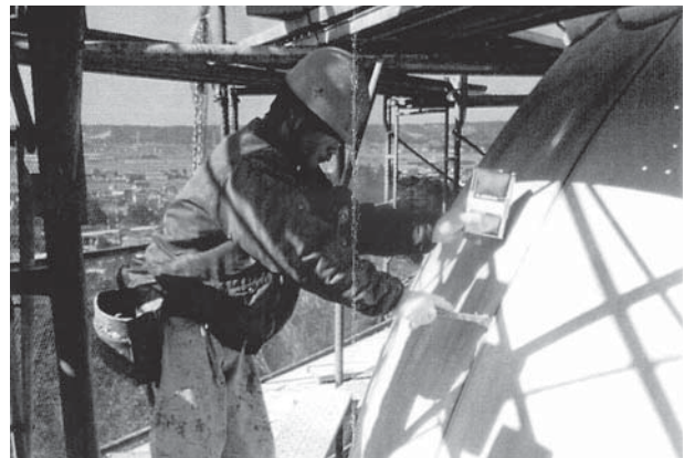
第2次保存修理 塔身上部モルタル仕上目地コーキング作業
