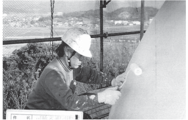
第2次保存修理 耐久性を考慮して仕上塗装を塗増し塗装
