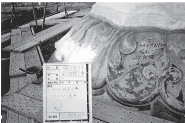
第2次保存修理 ハイボントコート塗布前プライマー処理状況
