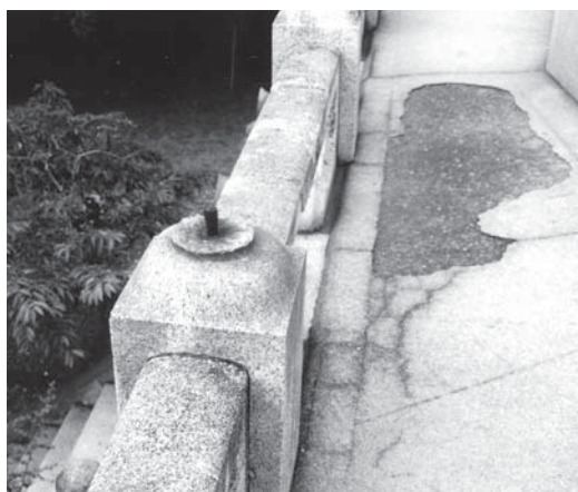
第2次保存修理前 基壇上部歩廊石柵破損状況
