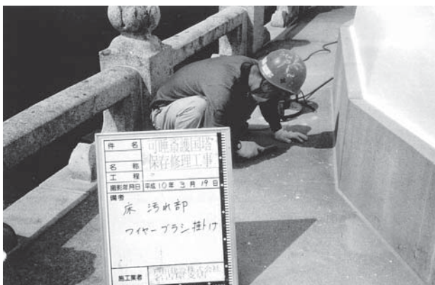
第2次保存修理 基壇上部歩廊防水剤塗布前汚落し作業
