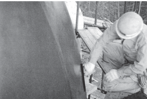
第2次保存修理 塔身上部防水モルタル塗作業
