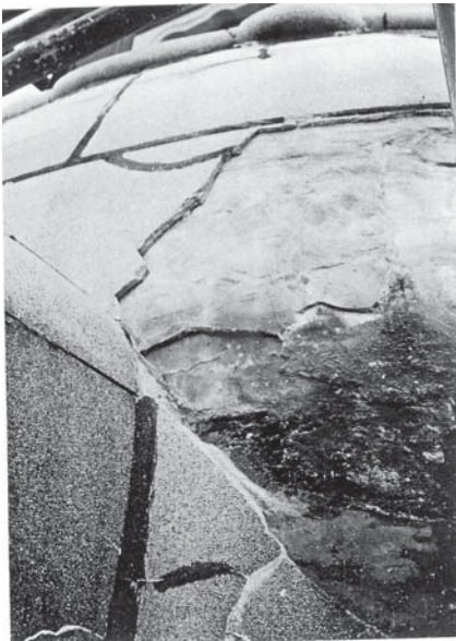
第 1 次保存修理前 劣化状況
