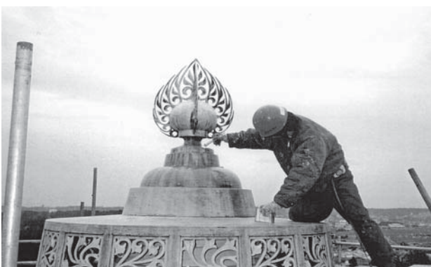
第2次保存修理 相輪防水剤塗布作業
