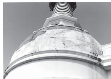
第2次保存修理前 塔身上部破損状況
