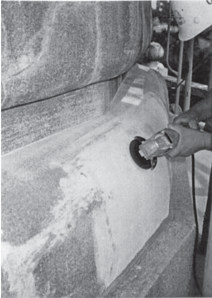
第 1 次保存修理 下地調整作業状況
