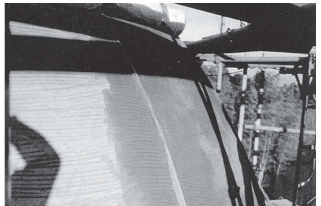
第2次保存修理 塔身上部上下塗モルタル塗状況
