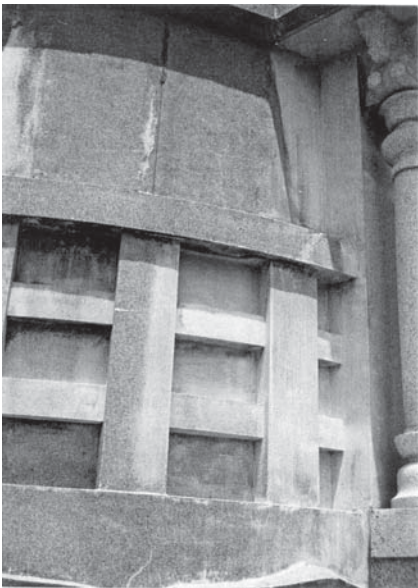
第 1 次保存修理前 劣化状況
