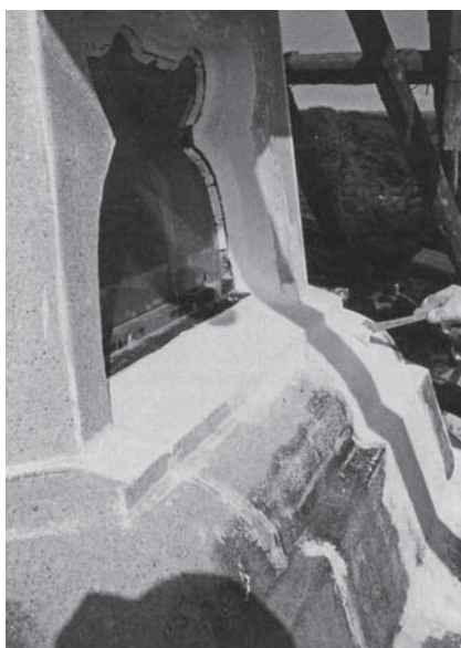
第 1 次保存修理 防水剤塗布作業状況
