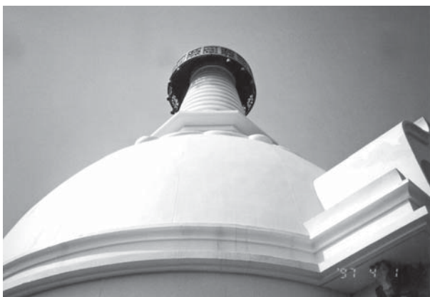
第2次保存修理竣工 塔身上部・相輪
