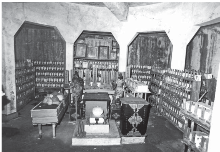
昭和 5 0 年代の地下室 祭壇付近状況
