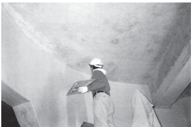
第2次保存修理 基壇内部梁部漆喰仕上げ作業
