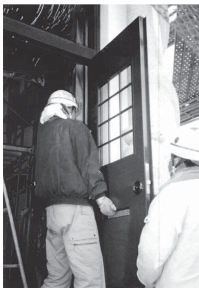
第2次保存修理 塔身建具取付作業
