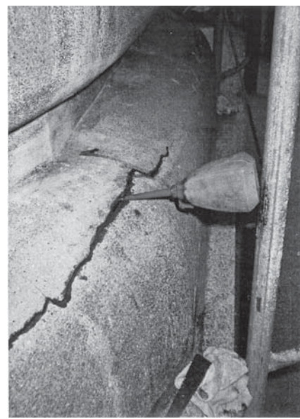
第1次保存修理 亀裂充填材状況
