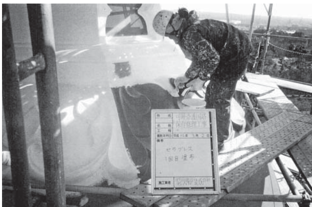
第2次保存修理 下地塗装作業
