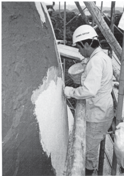
第 1 次保存修理 防水材塗布状況
