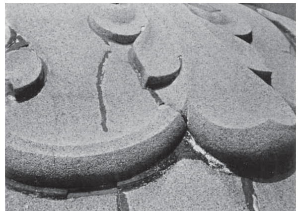
第1次保存修理前 劣化状況
