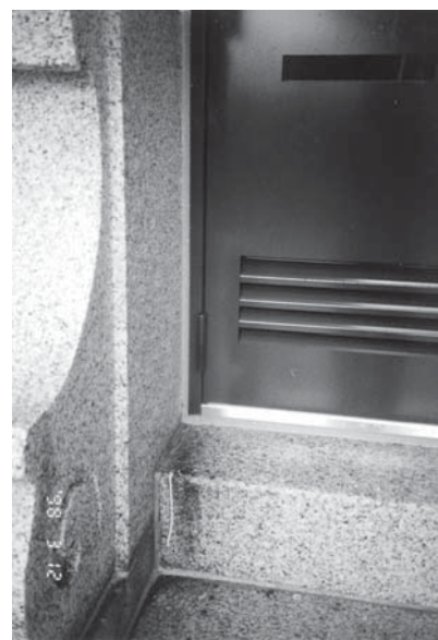
第2次保存修理 建具周囲コーキング状況
