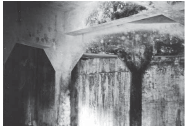
第2次保存修理前 地下室内部状況
