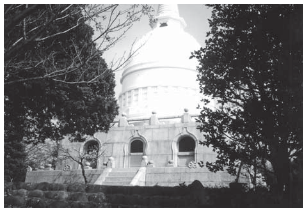
第2次保存修理竣工 塔身背面 遠景
