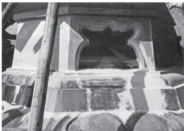
第 1 次保存修理 防水剤塗布下地調整作業状況
