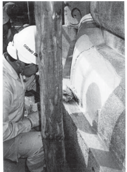
第 1 次保存修理 防水材塗布状況
