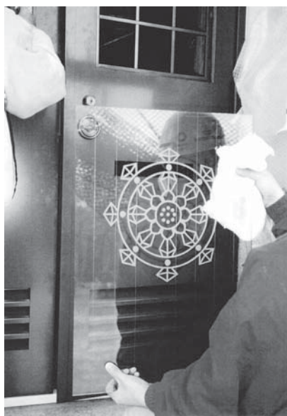
第2次保存修理 塔身建具取付作業
