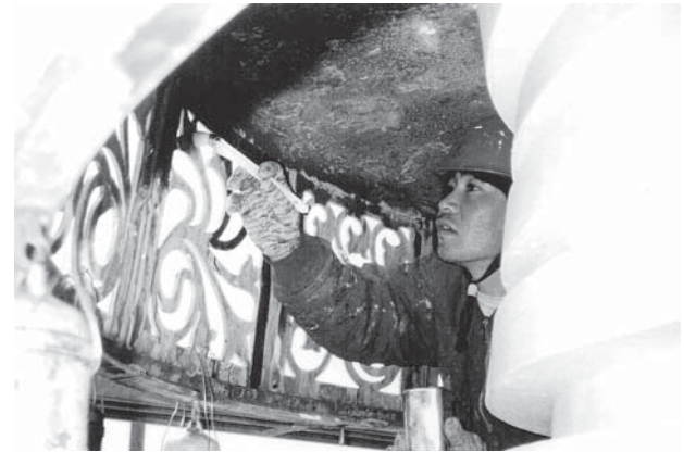
第2次保存修理 相輪防水剤塗布作業
