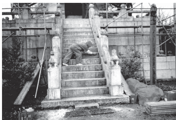
第2次保存修理前 基壇正面階段クリーニング作業
