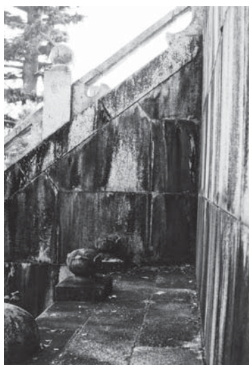
第2次保存修理前 正面階段状況
