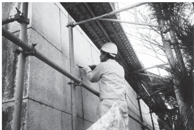
第2次保存修理 基壇下部目地補修作業
