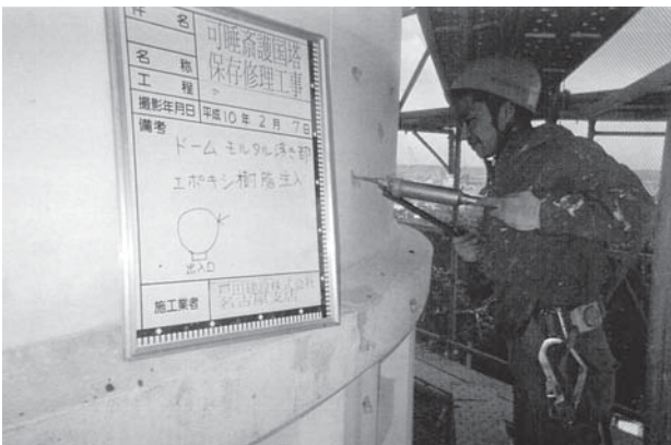
第2次保存修理 ステンレスピン挿入後エポキシ樹脂注入作業
