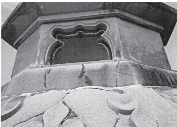
第1次保存修理前 劣化状況
