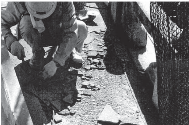
第2次保存修理 基壇上部歩廊表面不良箇所撤去作業
