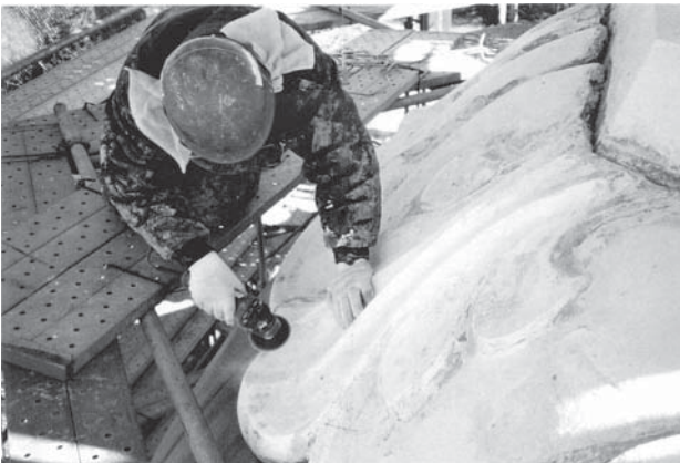
第2次保存修理 塔身上部旧塗装撤去作業
