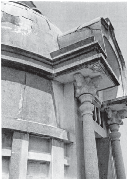
第 1 次保存修理前 劣化状況
