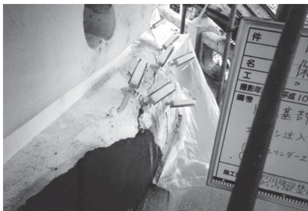
第2次保存修理 塔身下部亀裂再接着用ポルチ樹脂注入作業
