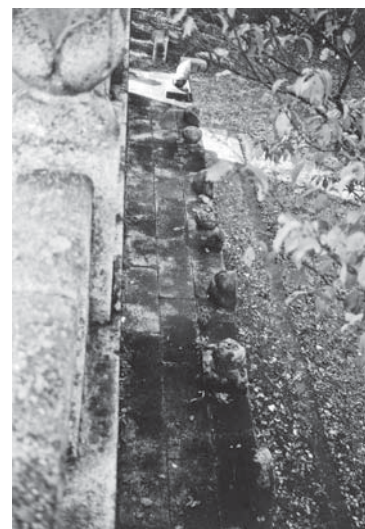
第2次保存修理前 基壇状況
