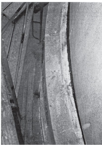
第 1 次保存修理 防水剤充填状況
