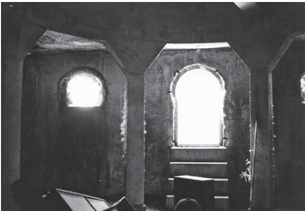
第2次保存修理前 地下室内部状況
