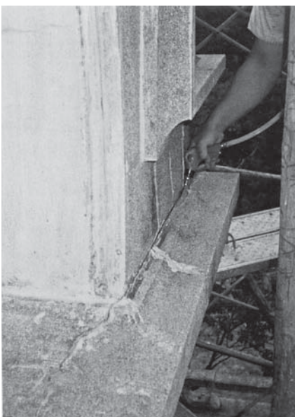
第1次保存修理 細部清掃状況
