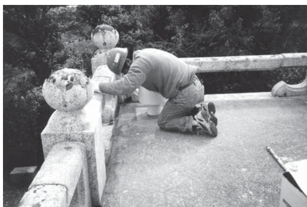
第2次保存修理前 基壇上部歩廊石柵破損状況
