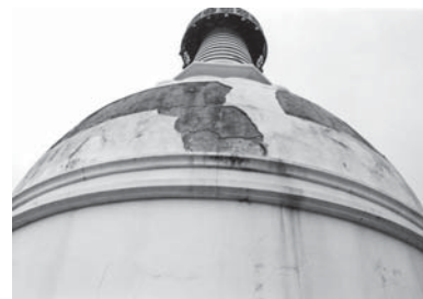
第2次保存修理前 塔身上部破損状況
