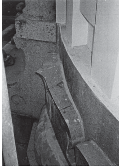
第 1 次保存修理 細部防水剤塗布状況
