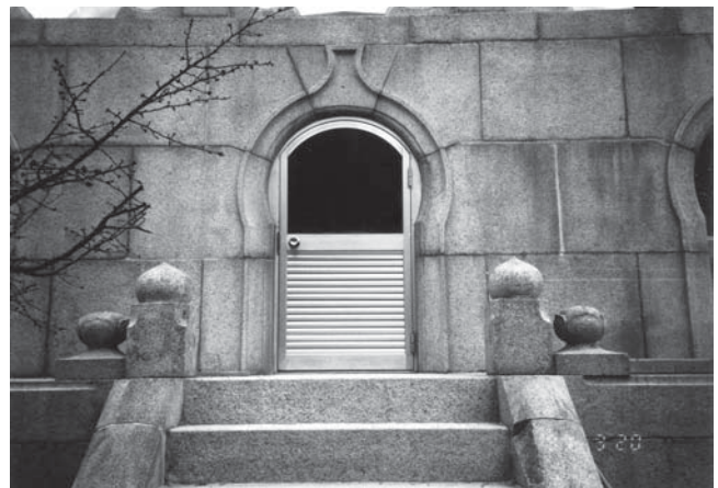
第2次保存修理竣工 基壇出入口
