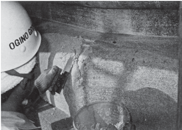
第1次保存修理 充填材塗布状況
