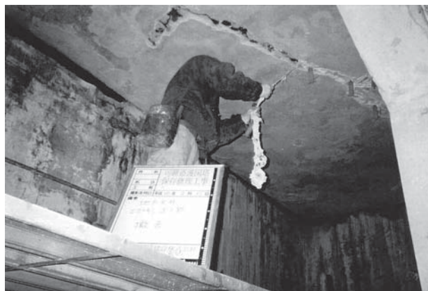
第2次保存修理 樹脂注入後クラックシール撤去作業
