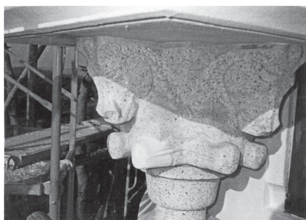
第 1 次保存修理 欠落石材補修作業状況
