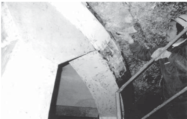
第2次保存修理 基壇内部付着藻類・かび類のケレン撤去作業
