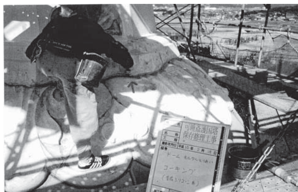
第2次保存修理 塔身上部と相輪基部取合部コーキング作業
