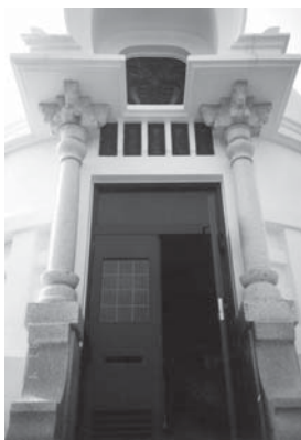
第2次保存修理竣工 塔身入口付近
