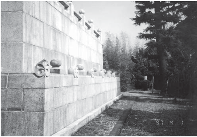
第2次保存修理竣工 南面基壇
