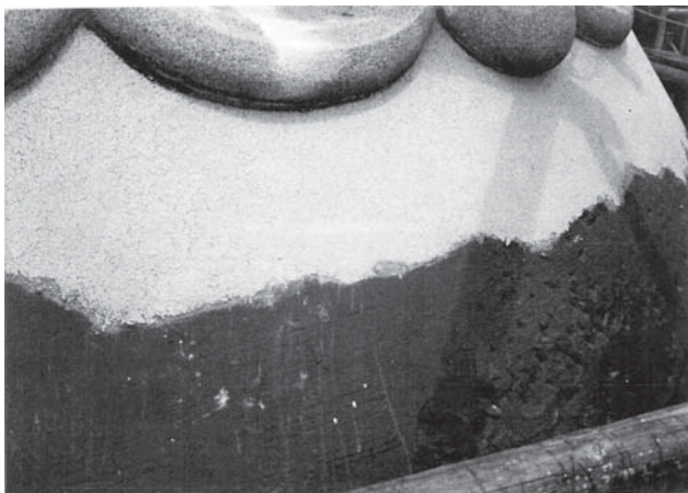
第 1 次保存修理 充填材及び防水材塗布状況
