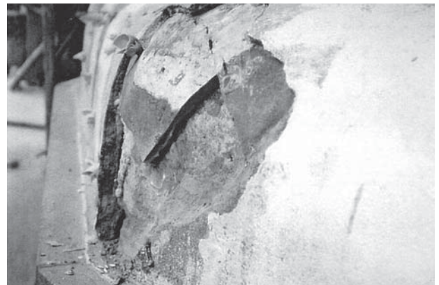
第2次保存修理 樹脂注入後の不良部はモルタル補修へ変更
