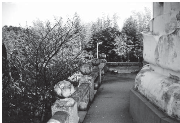
第2次保存修理前 塔身下部及び基壇上部状況
