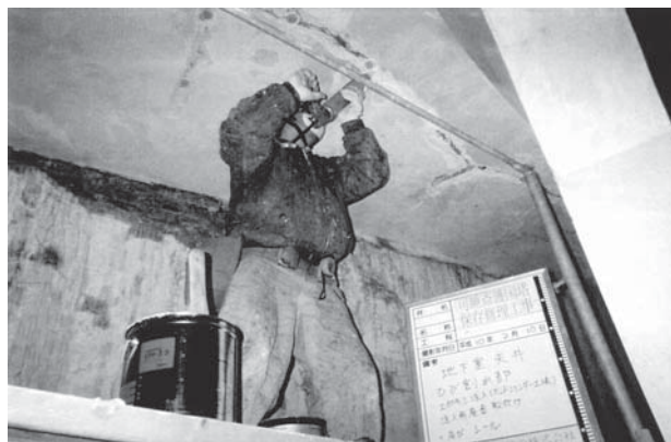
第2次保存修理 亀裂部へのエポキシ樹脂注入作業
