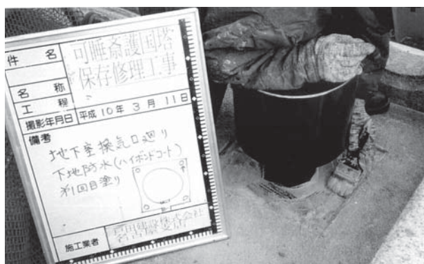
第2次保存修理 換気筒周囲防水処理
