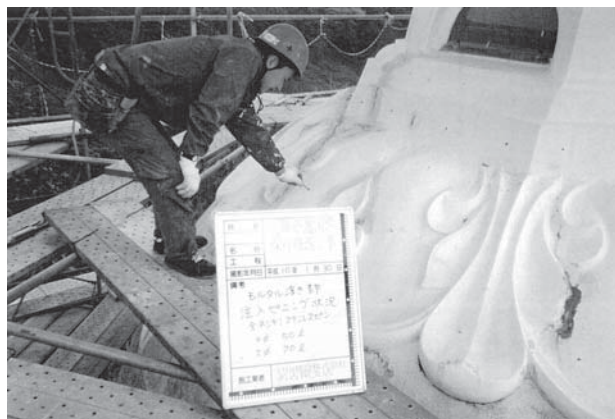
第2次保存修理 塔身上部剥落防止用ステンレスピン挿入作業
