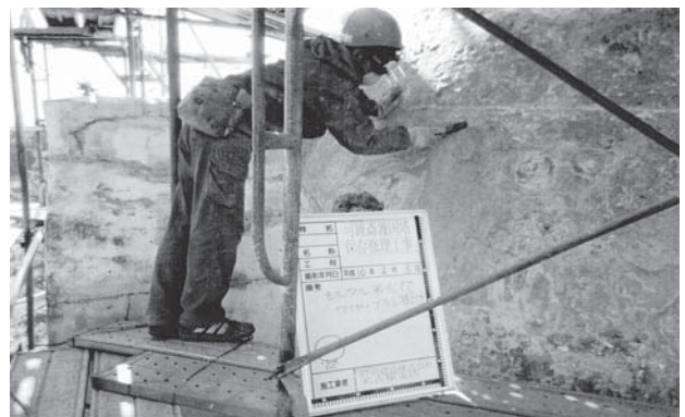
第2次保存修理 塔身上部表面材撤去作業状況
