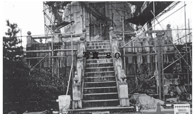
第2次保存修理 正面階段作業前状況
