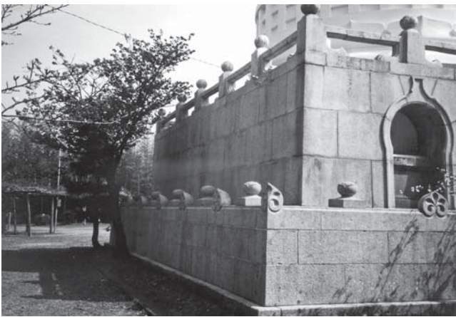
第2次保存修理竣工 北面基壇
