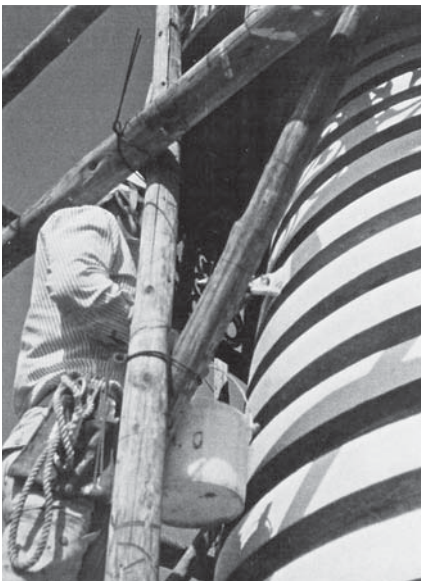
第1次保存修理 防水材塗布状況
