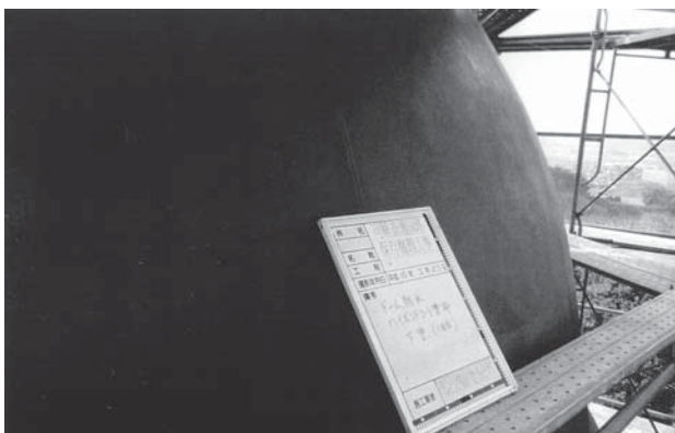
第2次保存修理 ハイボントコート防水剤塗布状況
