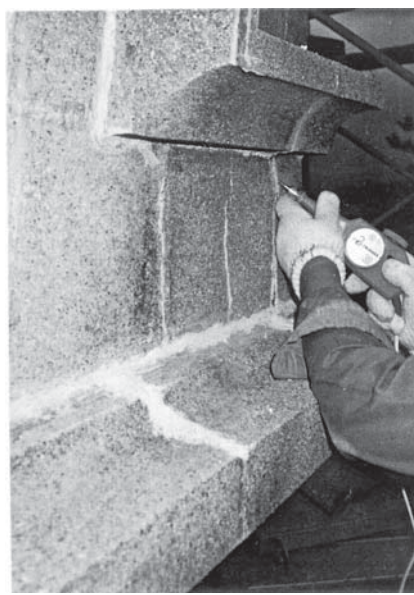
第1次保存修理 細部ハツリ状況
