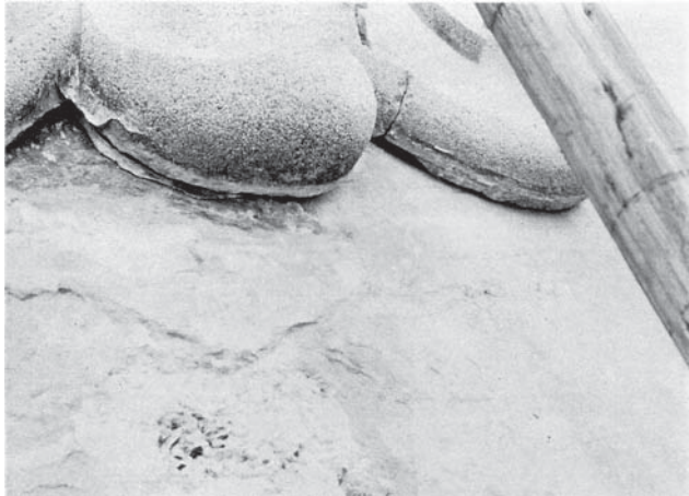
第 1 次保存修理前 劣化状況
