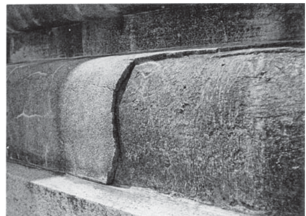
第1次保存修理前 劣化状況
