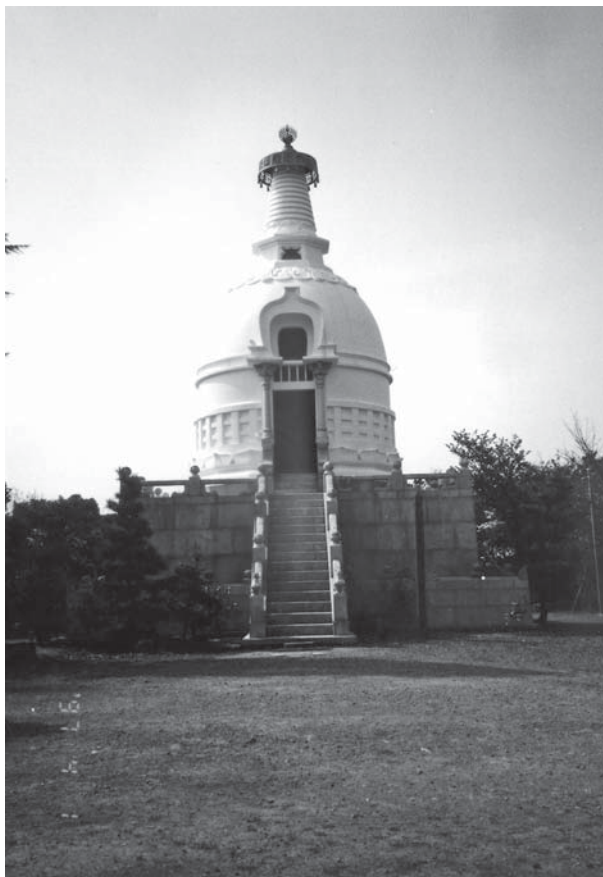
第2次保存修理竣工 正面
