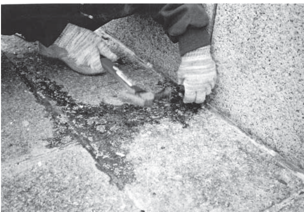
第2次保存修理 基壇目地より水抜き作業
