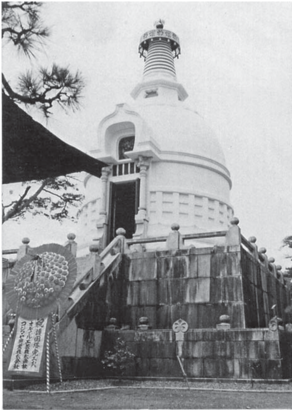
第1次保存修理竣工 北東より
