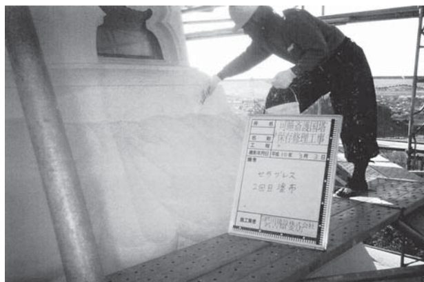
第2次保存修理前 中塗塗装作業
