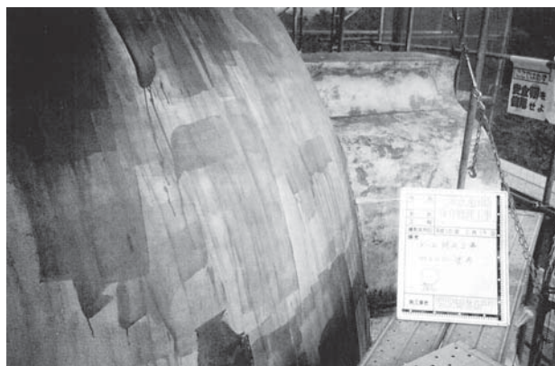
第2次保存修理 (ハイボントコート)下地処理プライマー塗布状況
