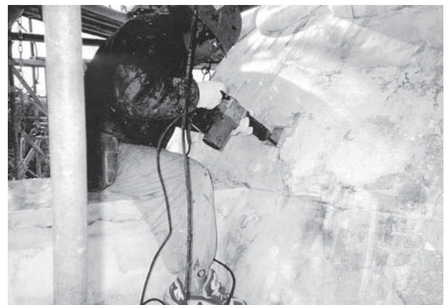
第2次保存修理 塔身上部中性化確認用開口作業
