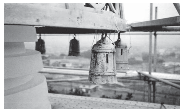
第2次保存修理 風鐸落下防止対策状況
