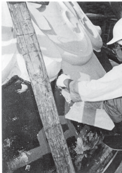
第1次保存修理 左官工事状況
