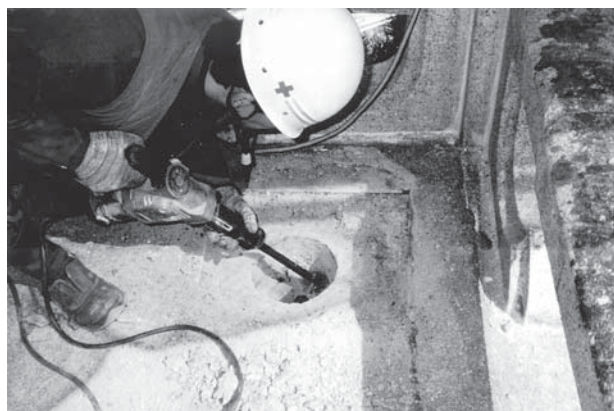
第2次保存修理 基壇上部歩廊への換気筒設置坑開口作業
