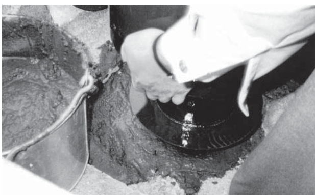
第2次保存修理 換気筒設置作業
