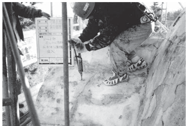
第2次保存修理 塔身亀裂再接着用ポルチ樹脂注入作業
