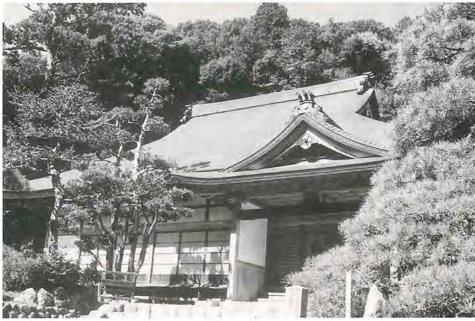
3-1 正法院跡（現尊永寺本坊）
