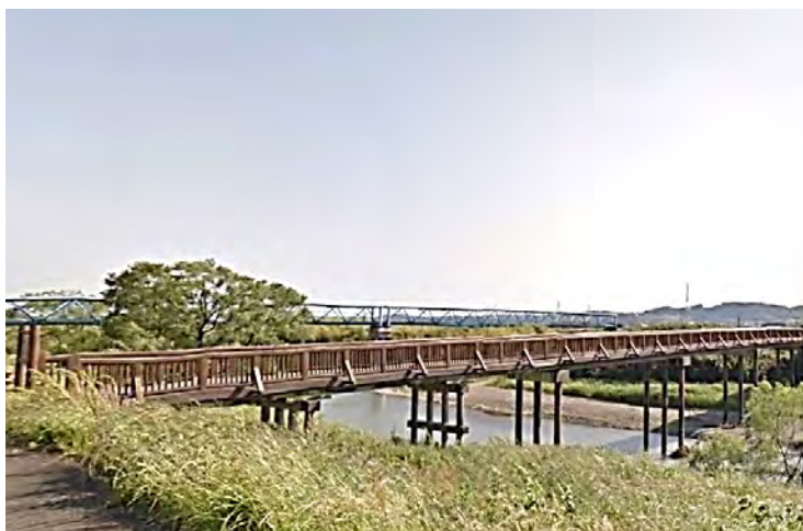
市道太田村松線新屋橋
