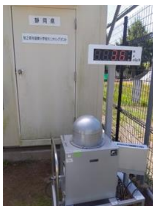
図 1 可搬型 MP の設置状況(萩間小学校 MP)
