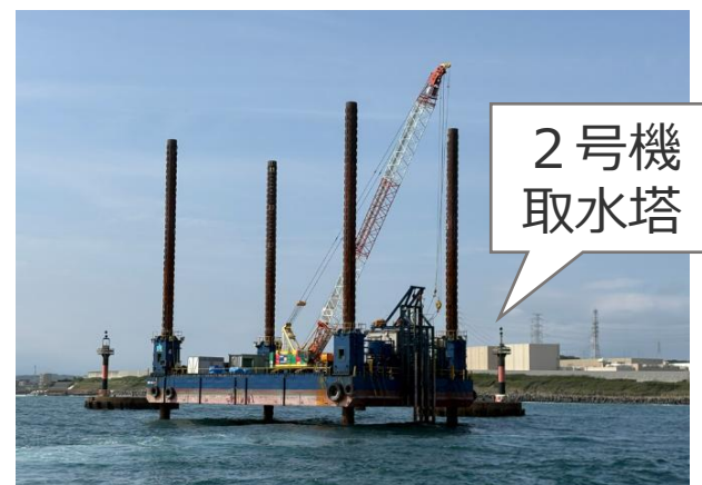
取水塔付近の作業船の様子
