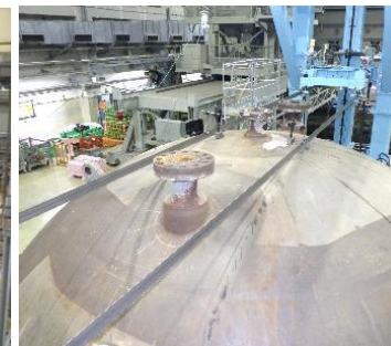
切断作業着手
