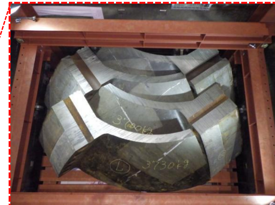
解体物は近傍のピット内へ収納
