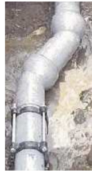
下水引込管の応急復旧の例
