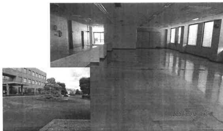
浅羽支所の全景と2階のスペース。災害対応できる大切なスペースだと提言している。
